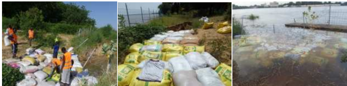
Du 1er au 10 octobre 2022: première tentative de rétention des eaux dans la partie effondrée de la berge...
