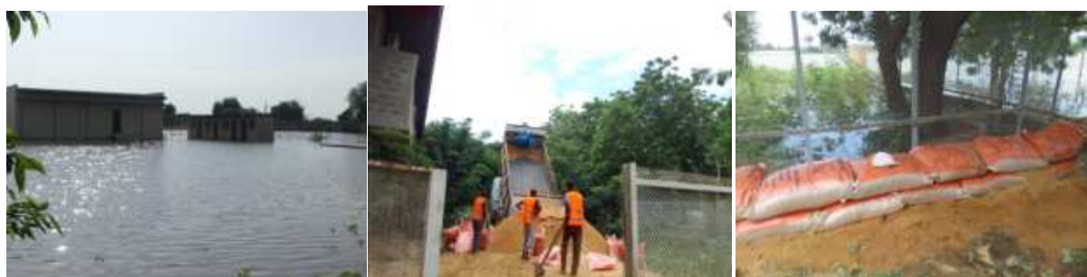
10.10.2022: le fleuve sort de son lit et envahit par endroit le site de l'hôpital; l'administration renforce le déploiement des sacs de sable pour freiner la propagation de l'eau. Plus de 600 sacs de sable ont déjà été posés à ce jour. Des solutions certes précaires face à l'ampleur du risque mais en constitue le moindre mal...
