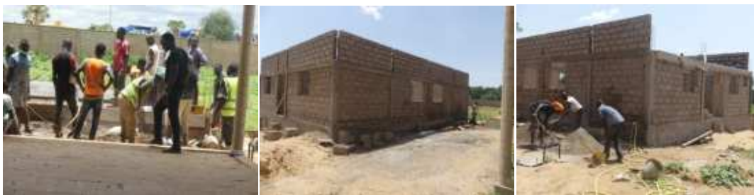
Travaux de construction du nouveau centre Nutritionnel
