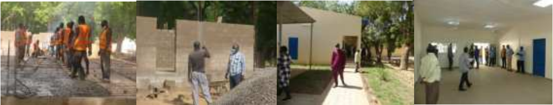
La construction de 04 salles de classe pour la faculté de médecine est achevée →
