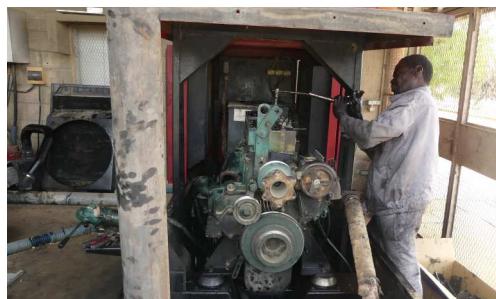
Un technicien démontant le moteur d'un groupe électrogène du CHU-BS pour le réparer
